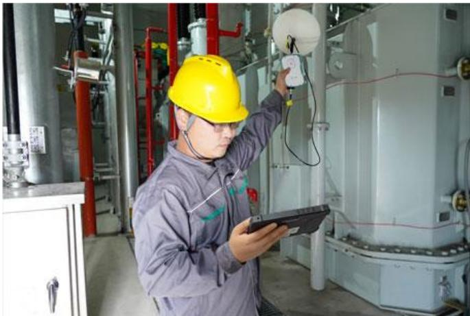
将传感器与主机连接，点击传感器图标切换到聚波器。
