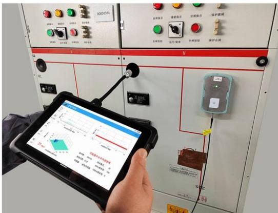
**测试前：**先在距离开关柜 2~3 米的位置将仪器对准空气，静止一段时间记录当前环境值。当环境值过大时，我们应找出干扰源，清除干扰源后再进行测试。
